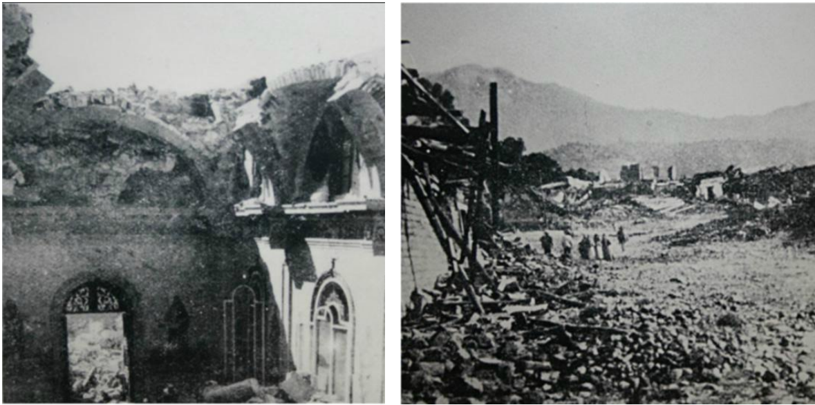
Figura 3. Daños causados por el sismo de Acambay de 1912. La fotografía de la izquierda muestra el derrumbe de la Iglesia de Acambay. La fotografía de la derecha es una imagen que evidencia el grado de destrucción en el poblado. (Tomadas de http://acamba3.wix.com/sismo-acambay-1912-2012#! )
